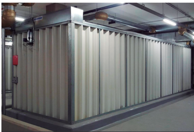
> Bancos de hielo de fusión interna de 2.5 MWh de capacidad. Fuente: Fafco
